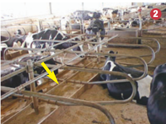
Divisions de logettes montées sur des barres horizontales dans une étable de construction récente. La barre inférieure (flèche) se trouve en plein milieu de l'espace avant.
